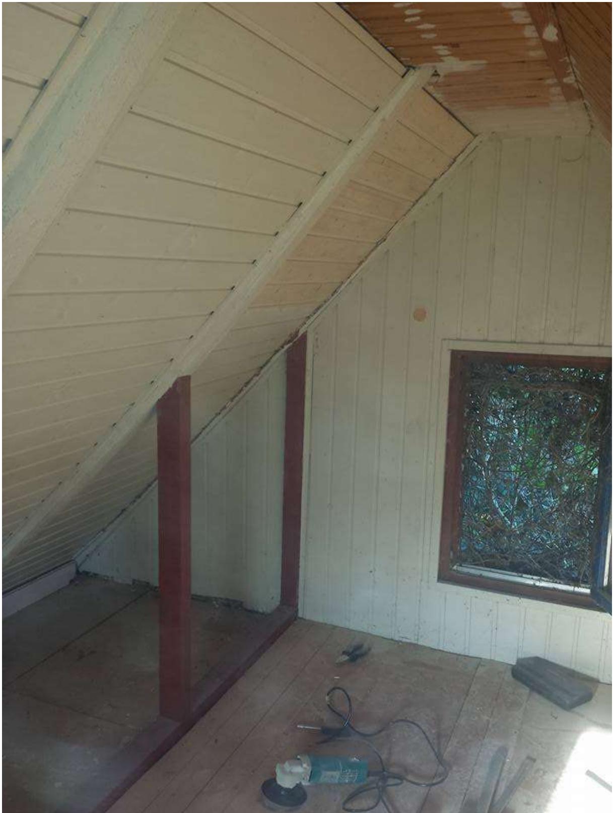
Tagelang schleife ich mit der Flex die Farbe ab. Es ist eine sehr staubige Arbeit!
