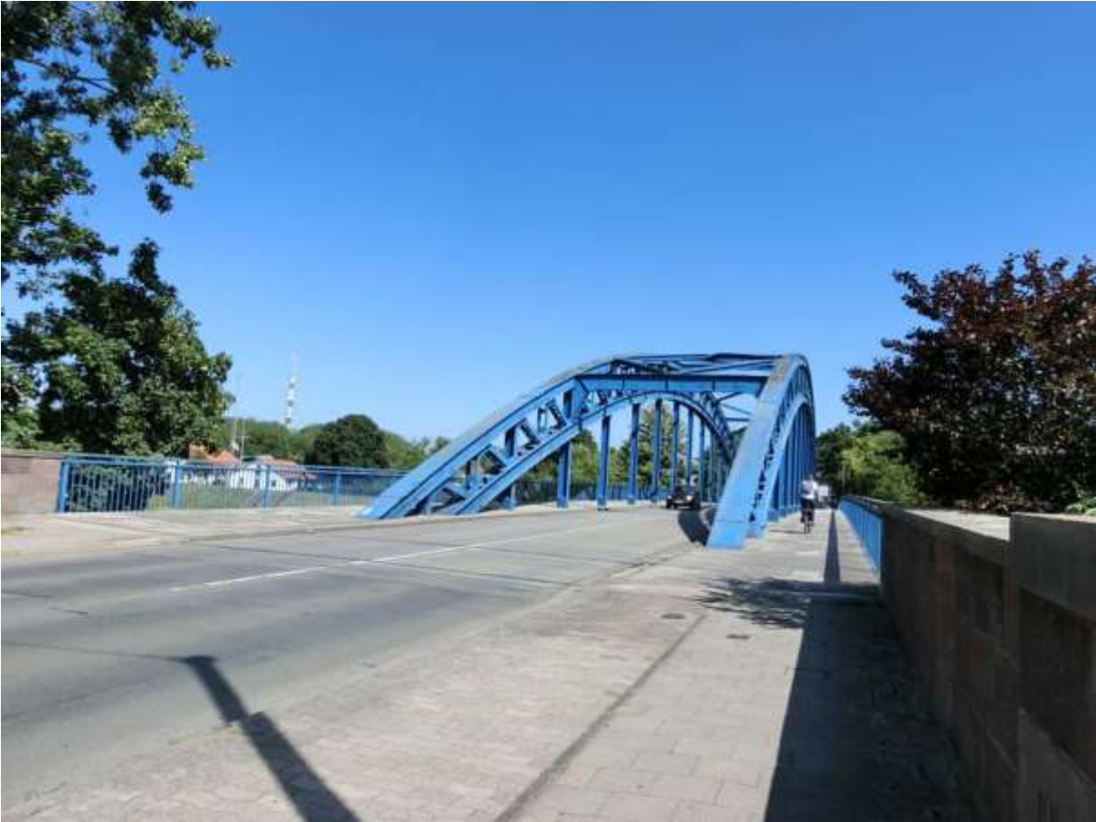
Weserbrücke in Nienburg
